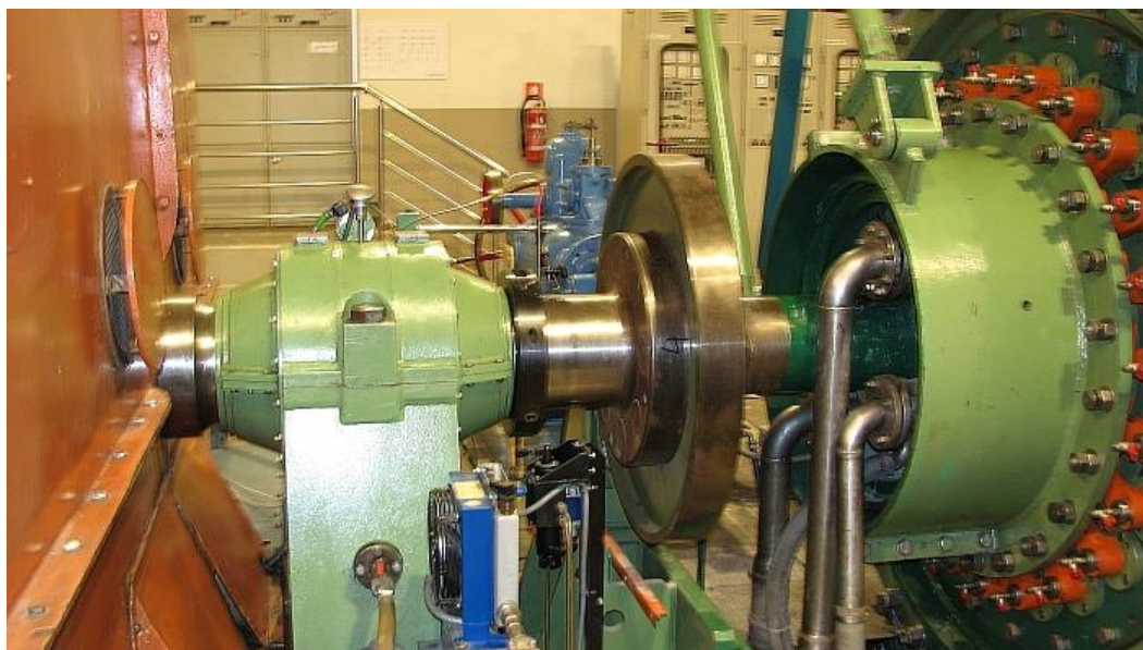
7. Beskontaktno mjerenje i analiza vibracija mjerenjem radijalnog vibracijskog pomaka na sklopu generator - turbina u hidrocentrali
