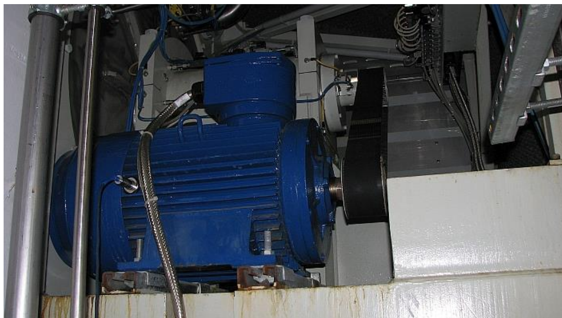
4. Elektromotor - mjerenje i analiza vibracija kućišta ležajeva na licu mjesta.
