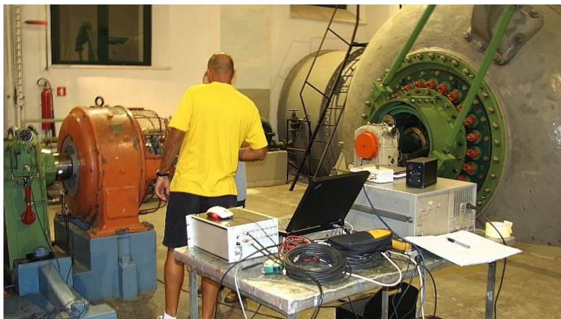
6. Beskontaktno mjerenje i analiza vibracija osovine generatora hidrocentrale.
